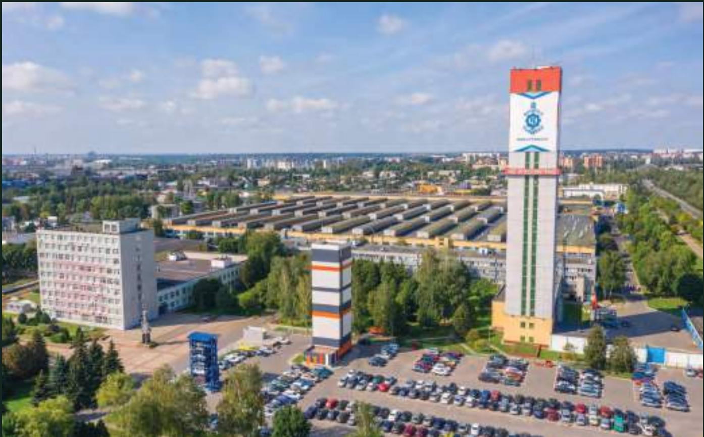
Одна из высотных доминант города — 84-метровая башня испытательного комплекса «Могилевлифтмаша». Отсюда весь Могилев и его окрестности — буквально как на ладони. Здание включает восемь сквозных шахт, в которых обкатывают экспериментальные узлы и агрегаты, проводят тест-драйвы серийных лифтов перед запуском в производство. Эта башня издалека встречает сотрудников и гостей предприятия.
