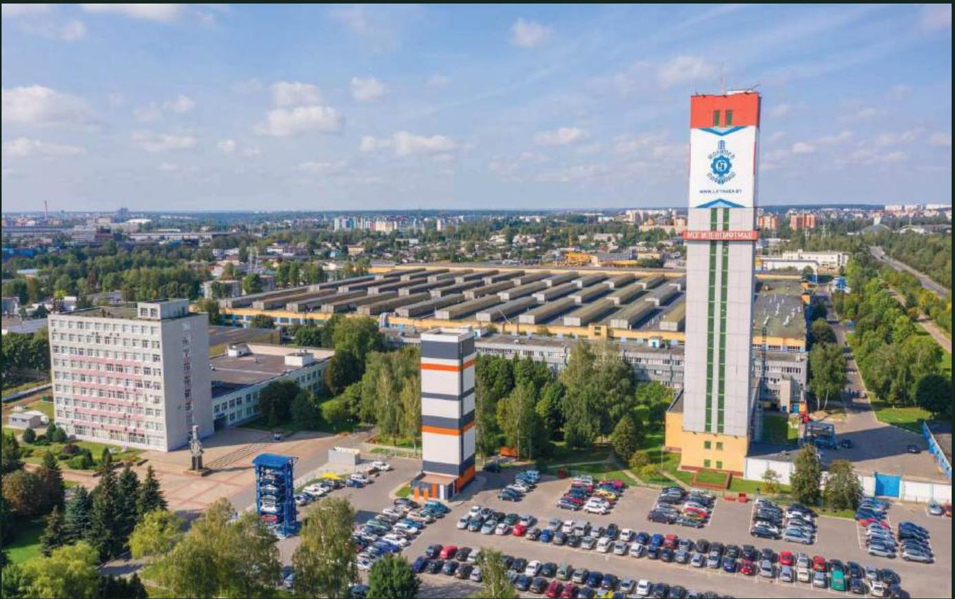
莫吉廖夫电梯机械厂84米高的试验塔是城市地标之一，巍然耸立。从塔上俯瞰，整个莫吉廖夫市区及周边风光尽收眼底。塔内设有八条贯通式井道，用于测试实验性部件总成，并对量产电梯进行投产前的试运行检测。这座高塔从远方迎接着每一位到访的企业员工和宾客。
