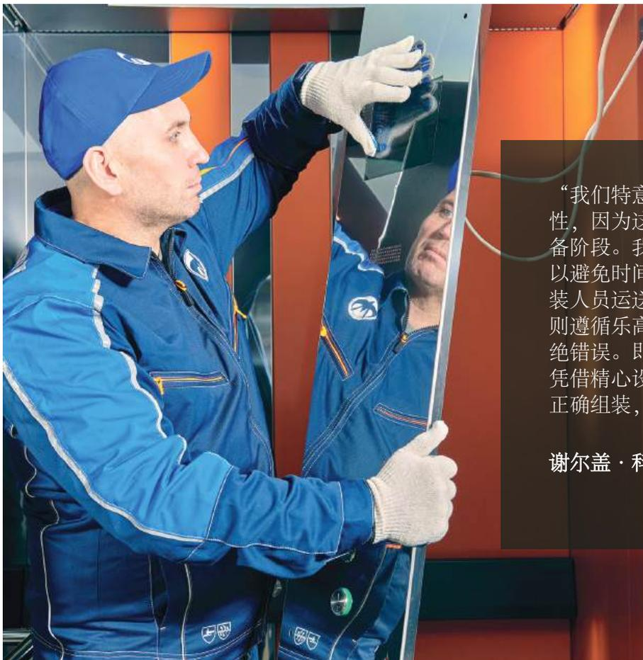
“我们特意向游客强调包装箱阶段的重要性，因为这实质上是在工地现场安装的预备阶段。我们会讲解如何配置载重单位，以避免时间损失。根据工作计划，只向安装人员运送必要的零部件，而设备的安装则遵循乐高积木的原则，以简化任务并杜绝错误。即使安装人员没有阅读说明书，凭借精心设计的对接系统，电梯也只能被正确组装，否则根本无法完成”。
