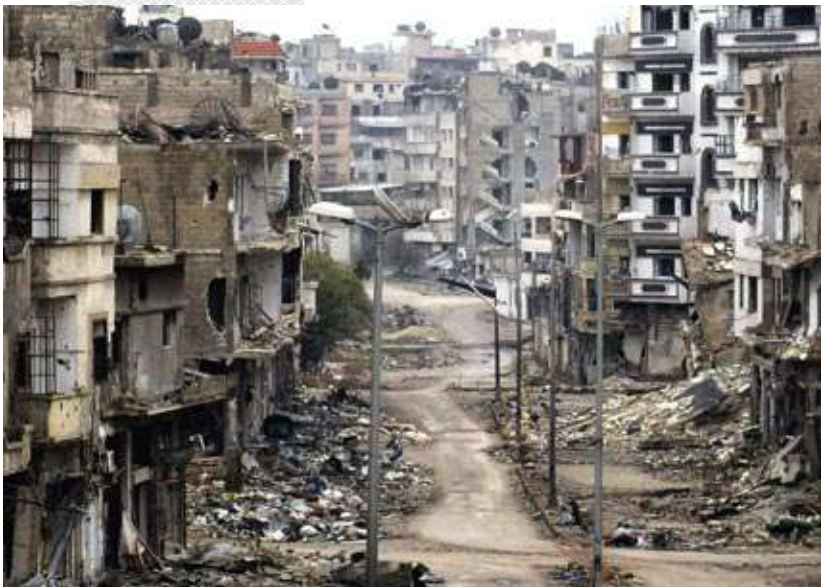
▼ Разрушенные жилые дома в Сирии. 2012 год
